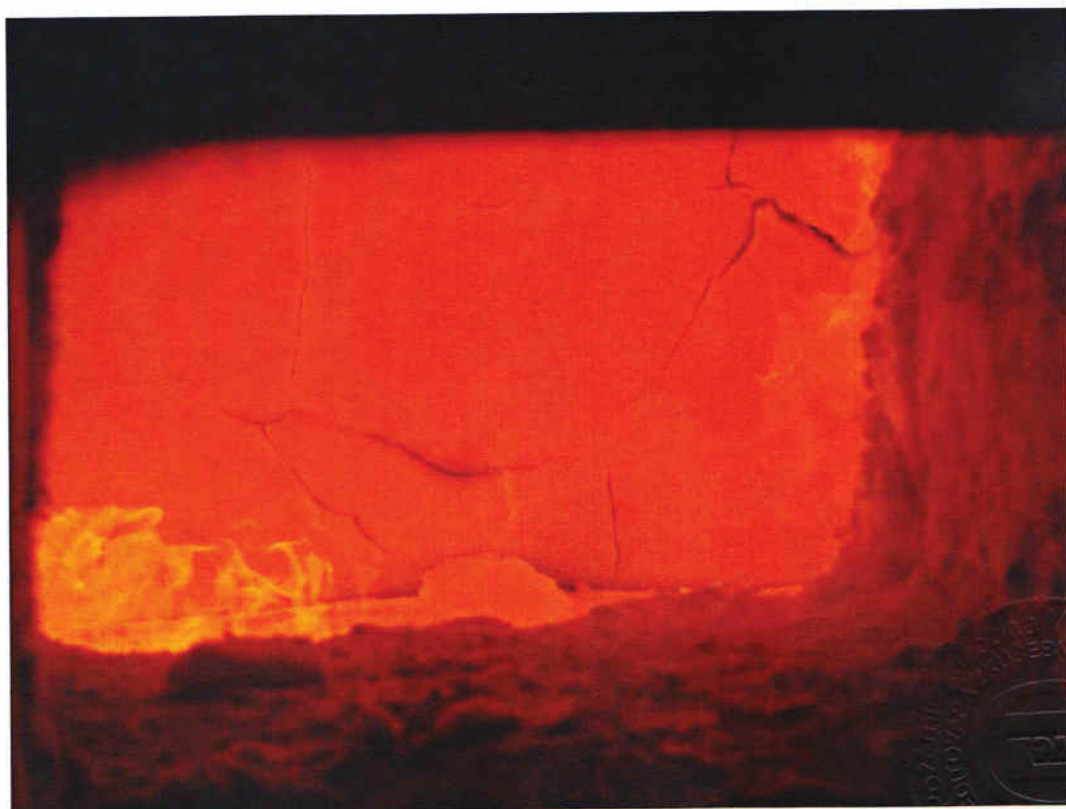
Trhliny v hliněné omítce OS – 138. minuta
