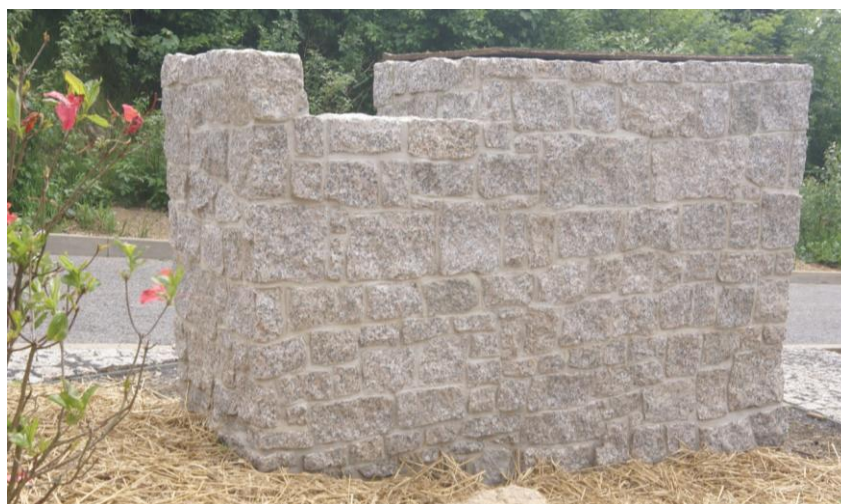
Ilustrační obrázek: zdivo z žulových odseků
